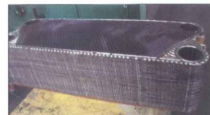
Fot. 5 Wymiennik płytowy rozbierny z instalacji c.o., zanieczyszczony osadem magnetytu po stronie niskich parametrów
