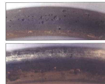
Fot. 7 Wżery korozyjne na rurekach grzejnych wymiennika przepływowego typu JAD (stal 304 AISI)
